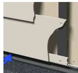
Należy zacząć od wąskiego paska płyty przy cokale
